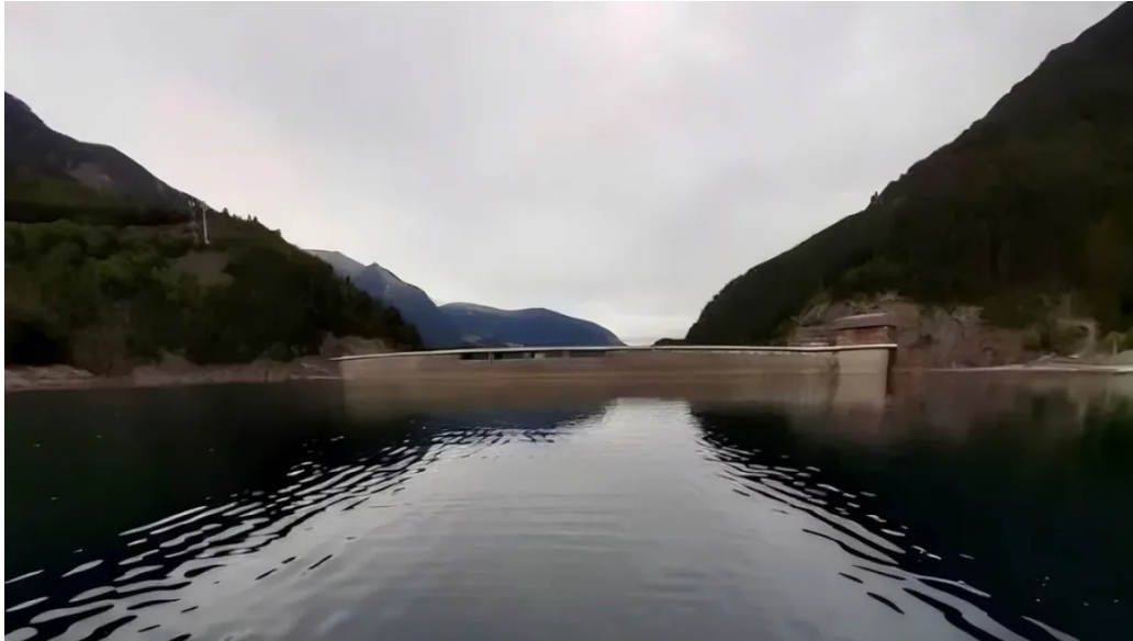
El embalse de Baserca almacena el agua que se bombea al de Llauset para ser turbinada de nuevo. - CHE
