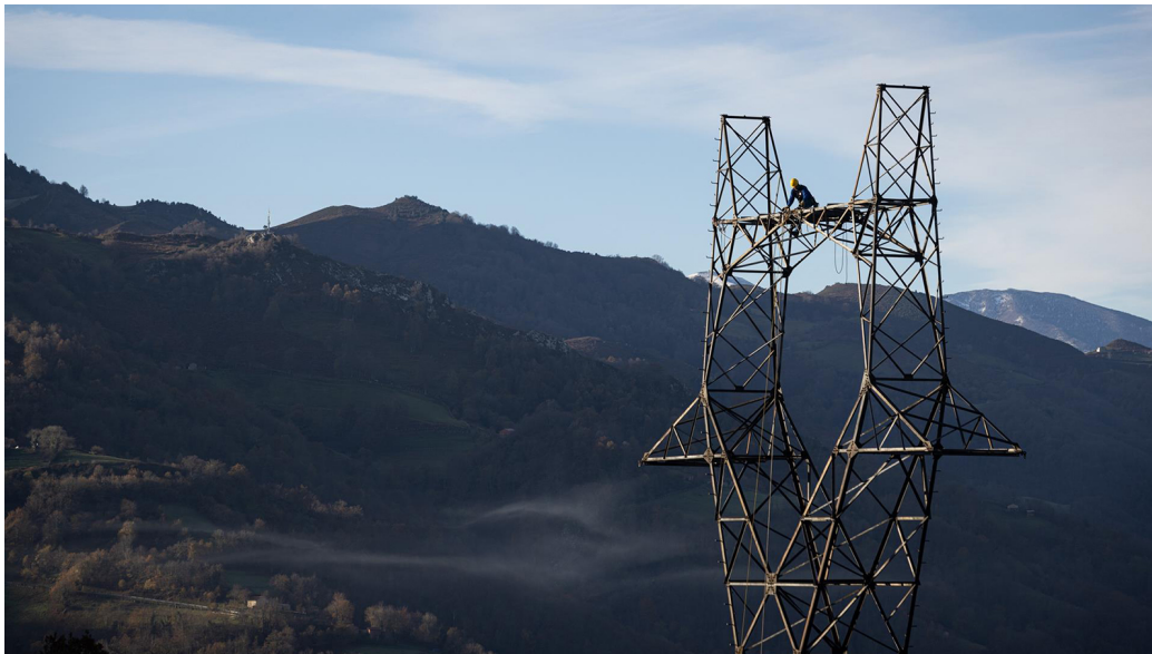
Una persona trabaja subida a una torre de alta tensión, durante una visita a las obras de desmantelamiento de la línea de alta tensión Lada-Velilla.
