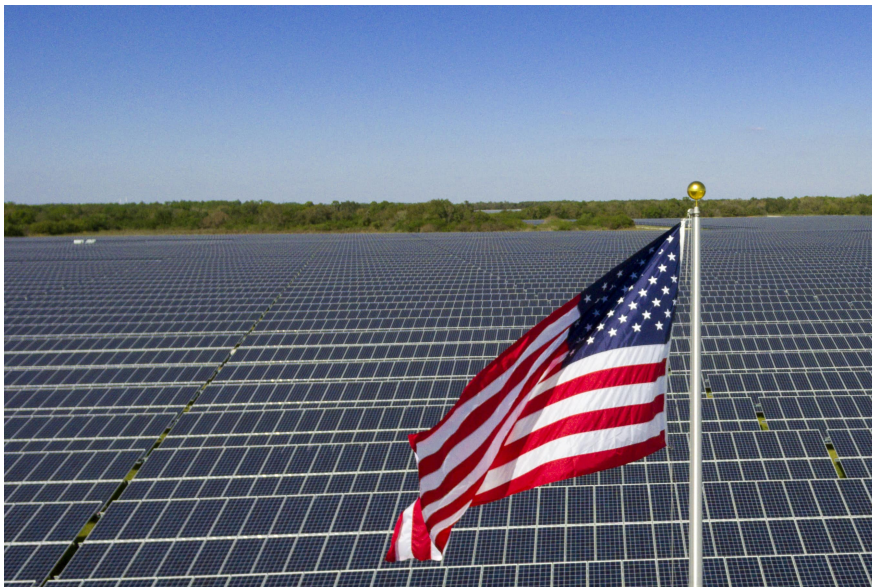
EEUU añadió 43 GW de nueva capacidad solar en 2025 en medio de una considerable incertidumbre
