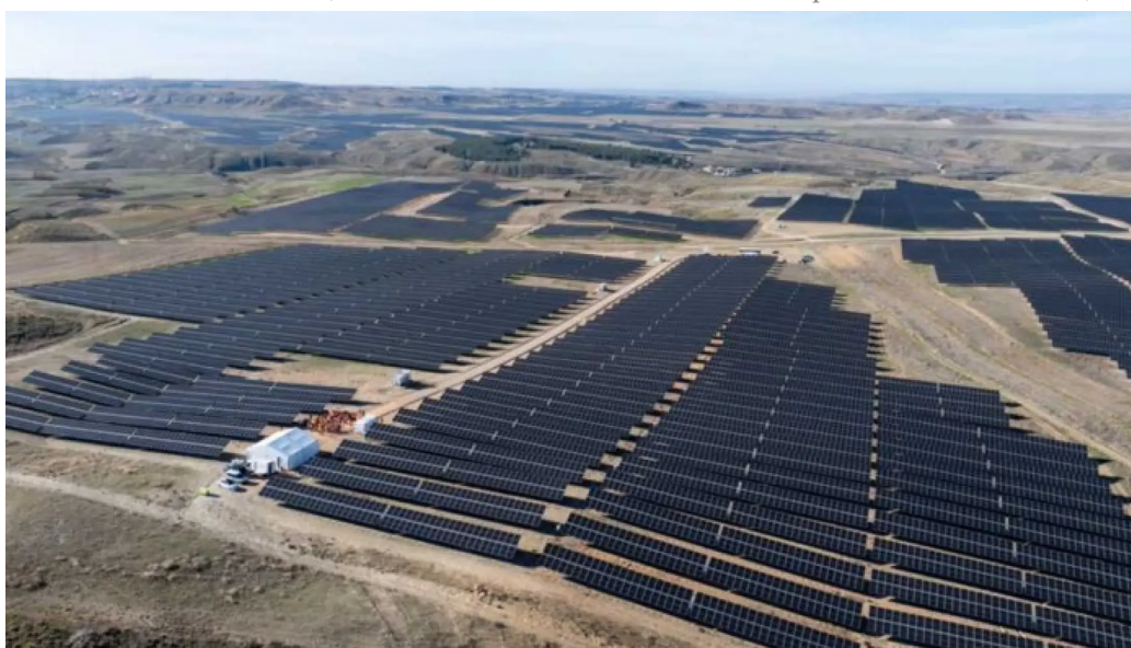
Planta fotovoltaica en la localidad conquense de Belinchón.
