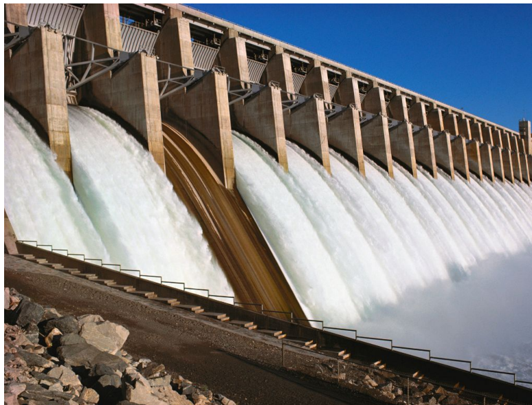
Hidroeléctrica Asturias Narcea
