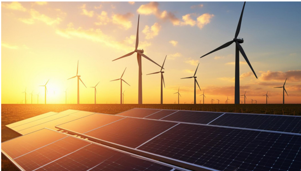
Instalaciones renovables de Enerside.
