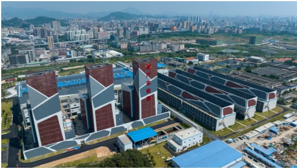
Central de ciclo combinado de Dongguan Ningzhou, de 2,4 GW, ubicada en la provincia de Guangdong, China.
