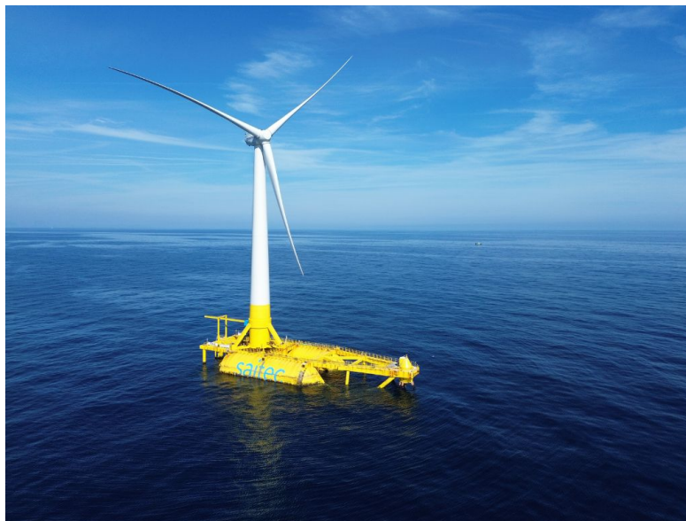
Proyecto DemoSATH, instalado en la costa vasca y en operación desde 2023.
