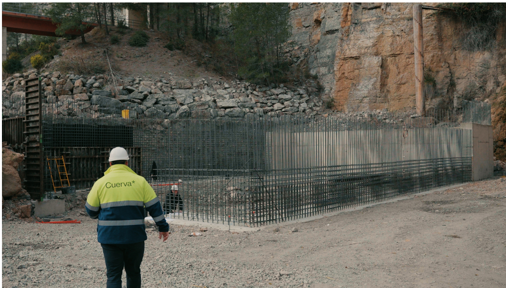
Cuerva avanza en la construcción de la Central Hidroeléctrica de Arenós en Castellón.
