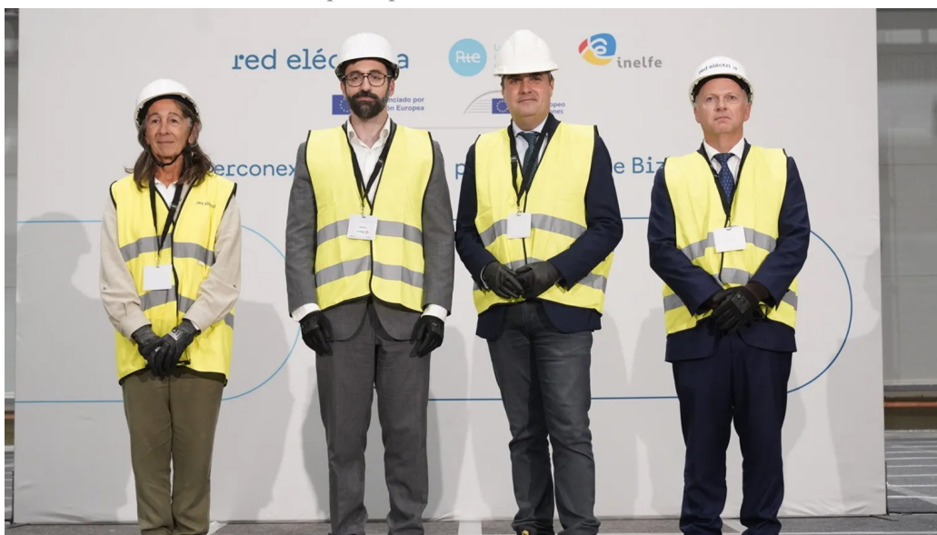
El secretario de Estado de Energía y el consejero delegado de Redeia visitan las obras de la interconexión con Francia por el Golfo de Vizcaya.
