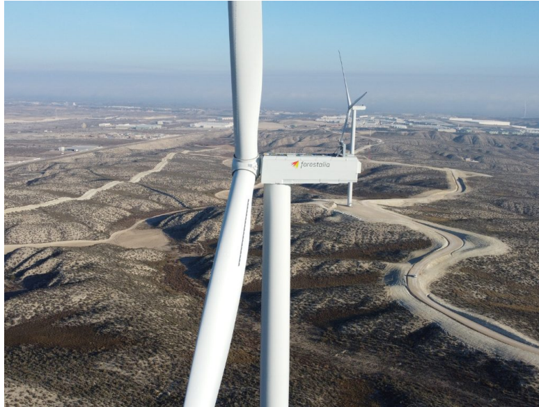
Forestalia instala 13 aerogeneradores en diversos parques eólicos en Tosos
