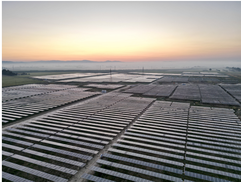
Planta fotovoltaica en Italia.
