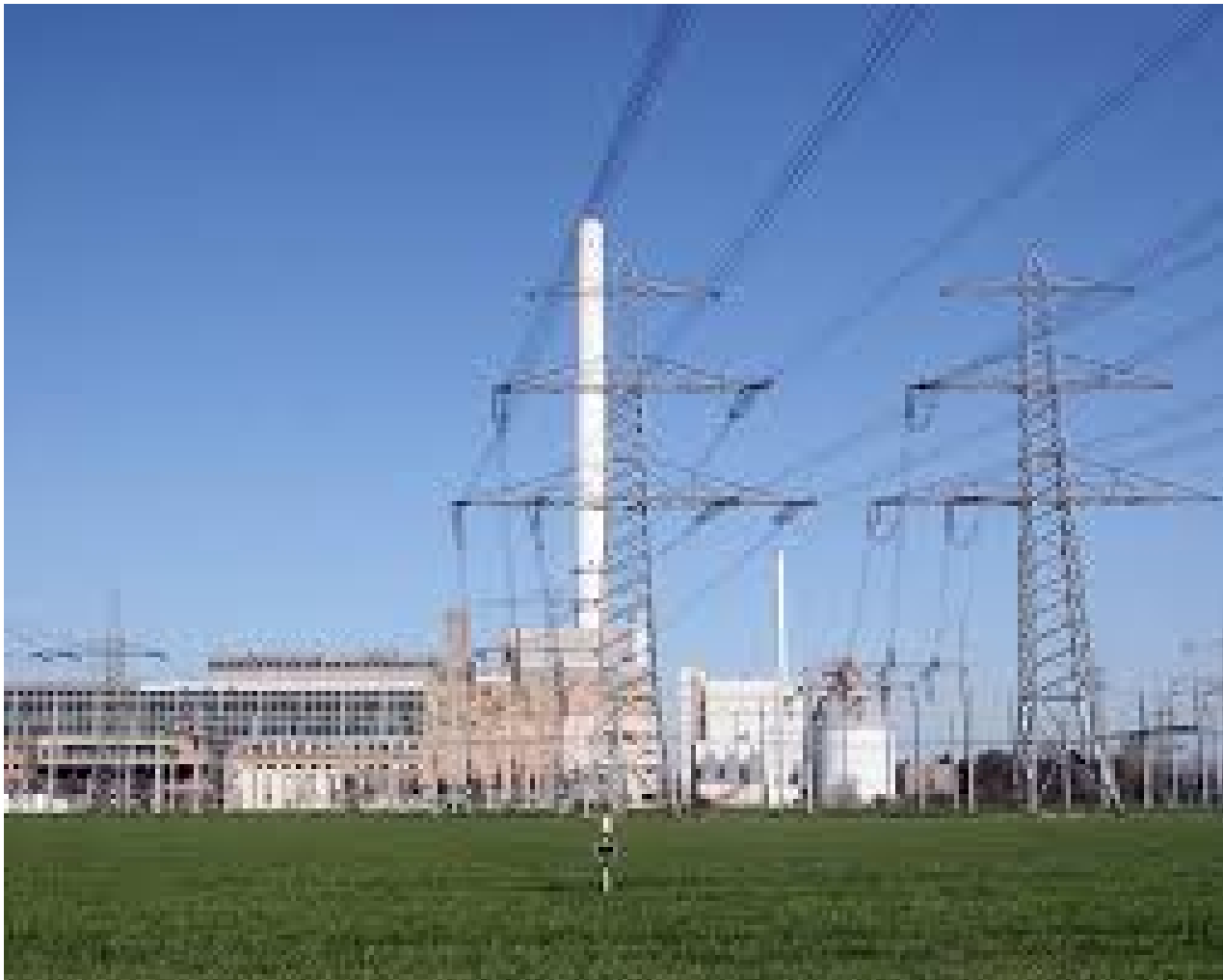
La Policía alemana investiga otro posible sabotaje en una subestación en el oeste del país
