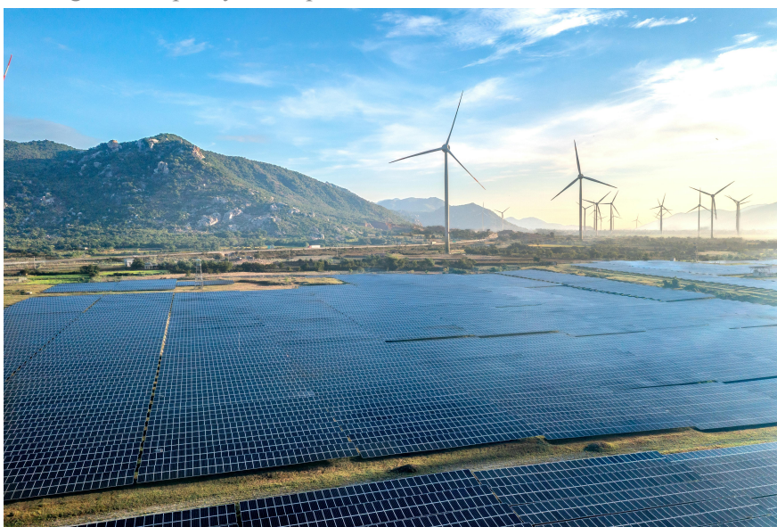
Cómo proteger las plantas de energía solar y los parques eólicos en lugares remotos
