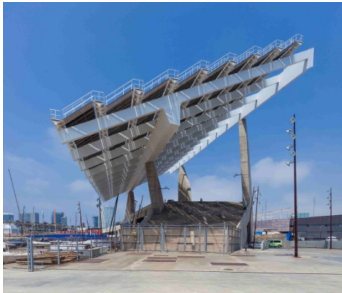
Las 312 instalaciones fotovoltaicas del Grupo Torsa elevan un 20 % su generación renovable
