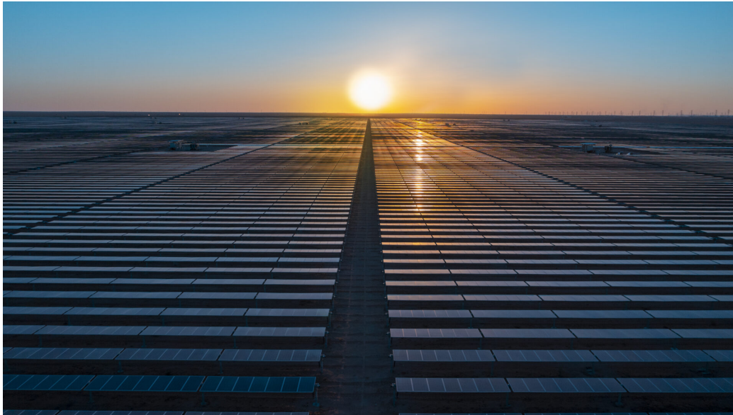
Planta solar fotovoltaica de Sakaka en Arabia Saudí. FOTO: ACWA Power.
