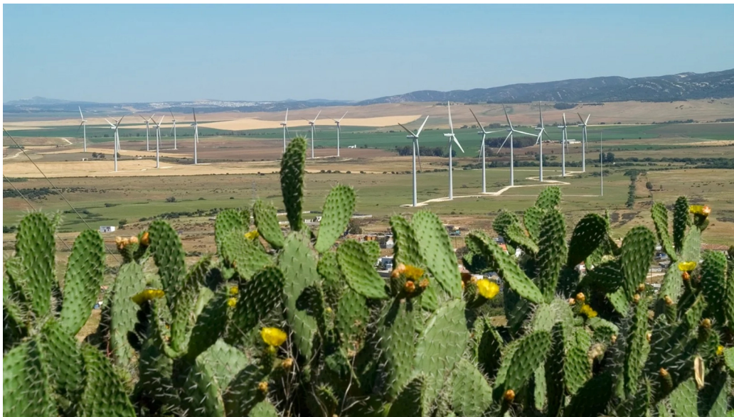
Parque eólico de Statkraft La Herrería antes de la repotenciación.
