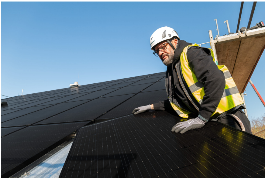
Un instalador de Solarwatt coloca paneles solares en un tejado.
