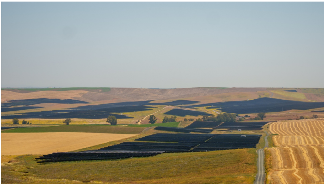
Imagen de una planta de energía solar en Carmona (Sevilla).
