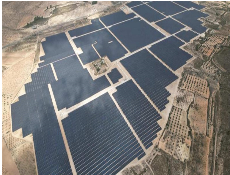
Vista aérea de la planta solar de Balbona (Murcia).
