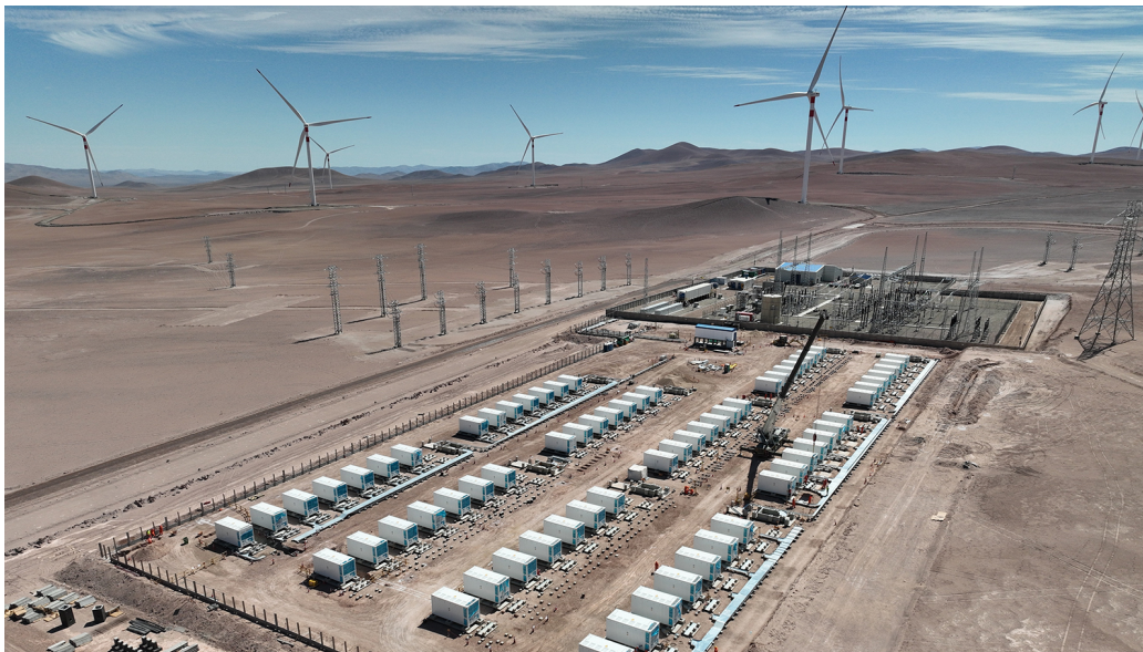
Engie avanza en la construcción de su primera batería híbrida con eólica en Chile.
