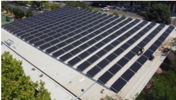
Instalación sobre la cubierta de la pista de patinaje de la Escuela de Gimnasia
