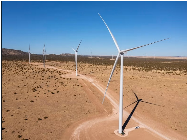
El parque eólico SunZia tiene una capacidad de 3.650 megavatios.
