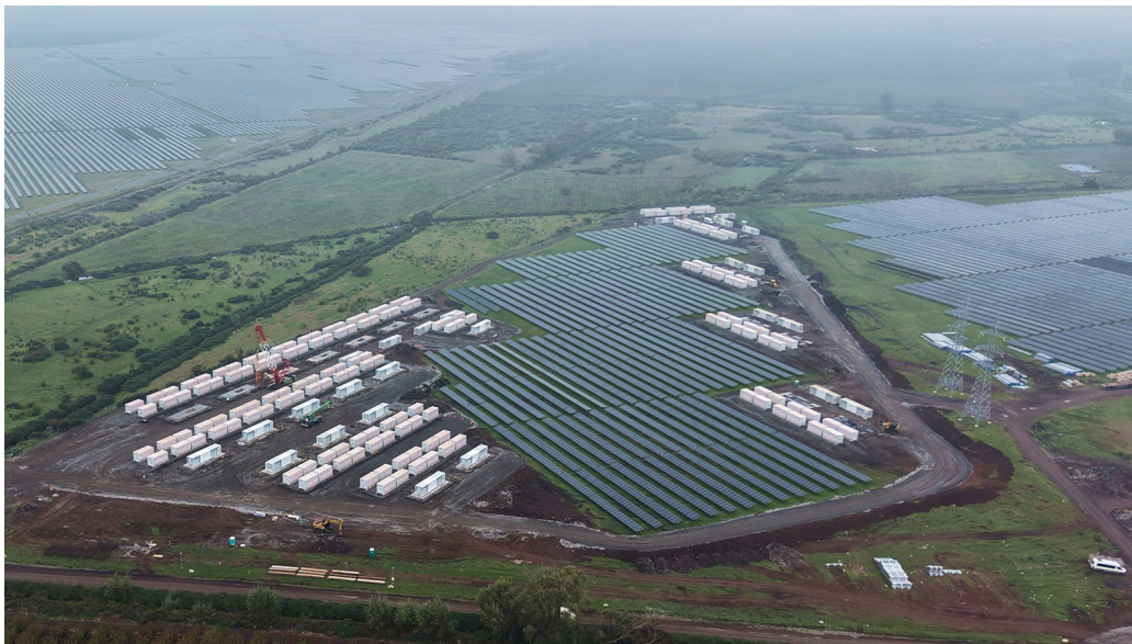
Planta sola Monte Águila de Grenergy en Chile.
