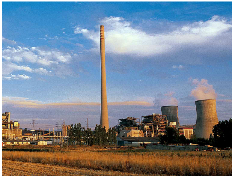
La voladura de las torres de refrigeración de la central térmica de Endesa de Compostilla, en Cubillos del Sil (León).
