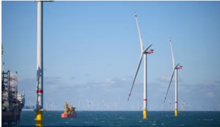
EnBW suministrará a Google 100 MW de energía eólica marina en Alemania con un contrato a 15 años
