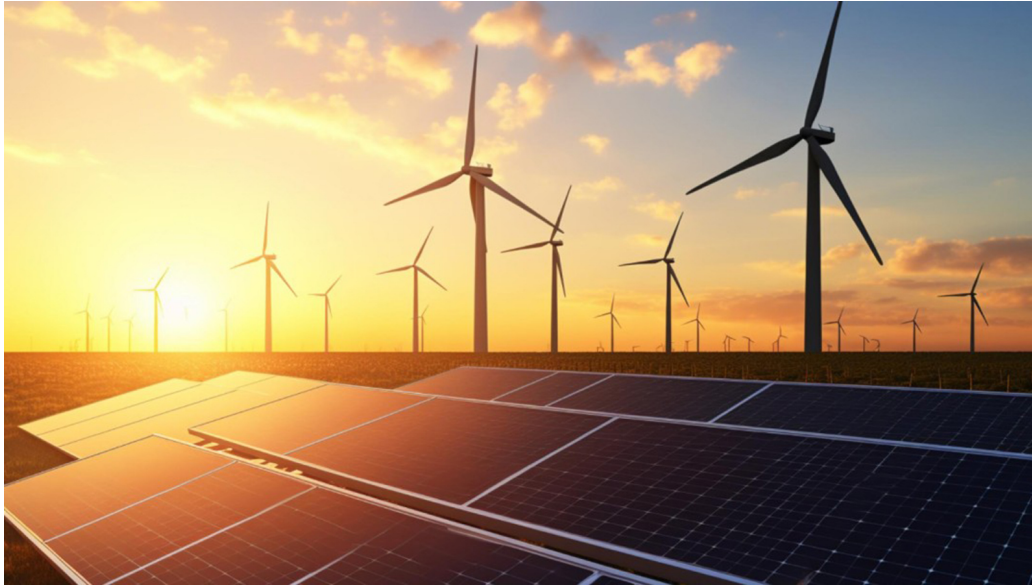
Instalaciones renovables de Enerside.
