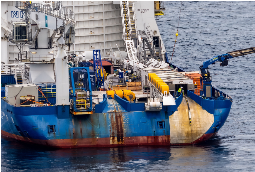
Red Eléctrica inicia el tendido del cable submarino de la interconexión con Francia por el Golfo de Bizkaia
