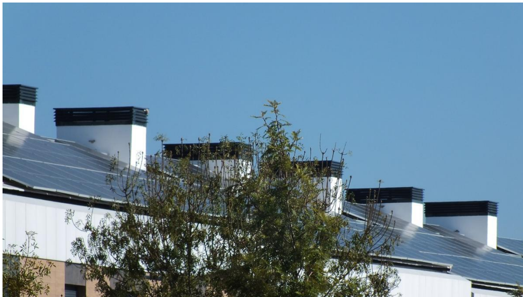
Placas solares en un edificio residencial.
