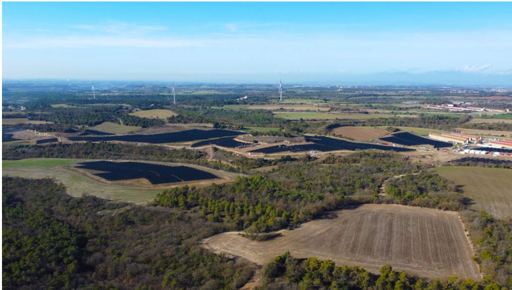
La planta fotovoltaica Carbeso Solar de Ignis.
