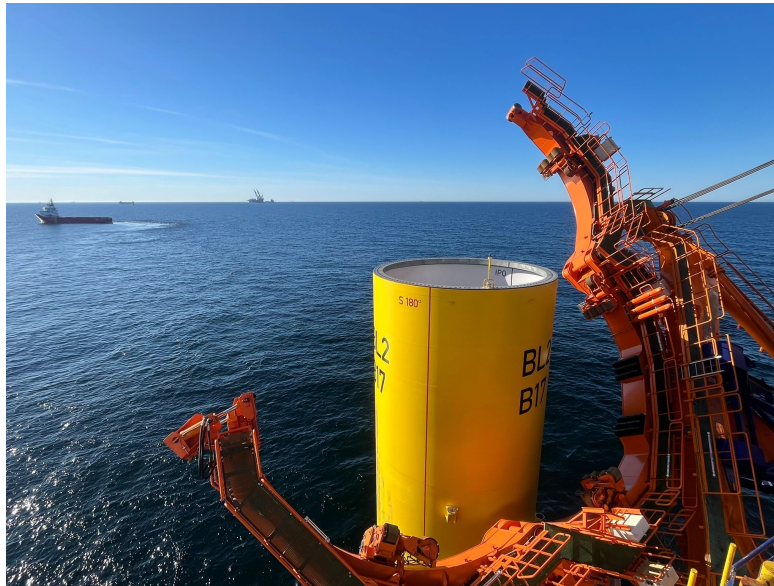
Ørsted y PGE inician la instalación del proyecto eólico marino Baltica 2
