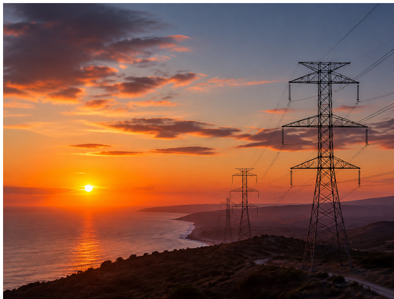
infraestructura de redes
