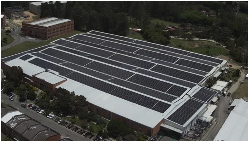
Instalaciones de Atera Energy.
