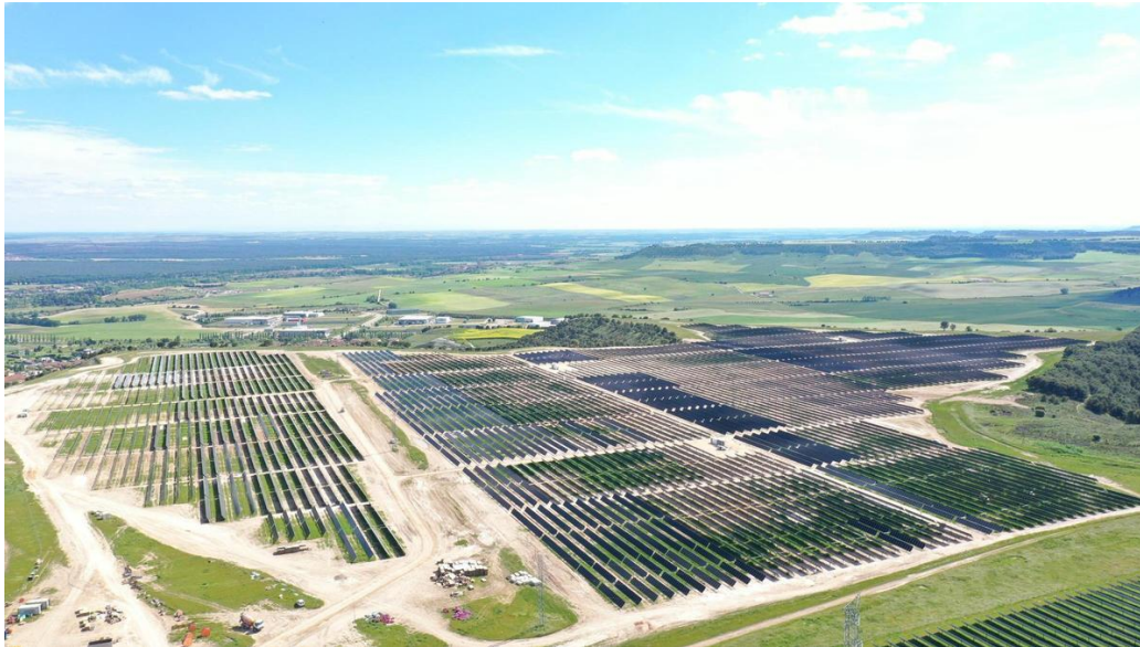
La planta fotovoltaica que ha construido y puesto en marcha en Valladolid la empresa aragonesa lasol.
