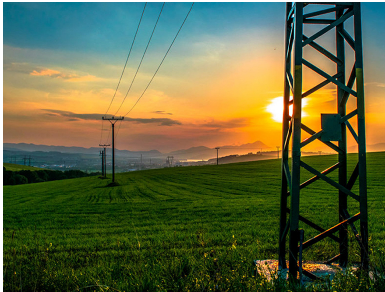
El sector eléctrico pide revisar la fiscalidad de la luz ante su "salvaje" carga
