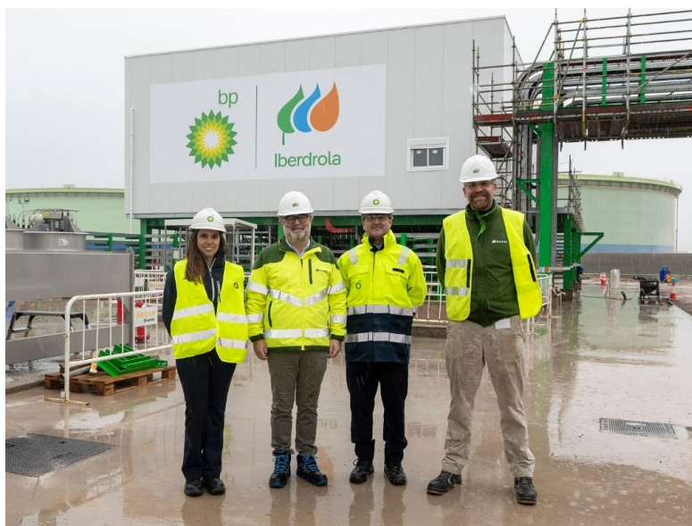
La planta de hidrógeno verde de Bp e Iberdrola en Castellón alcanza el 90% de construcción.
