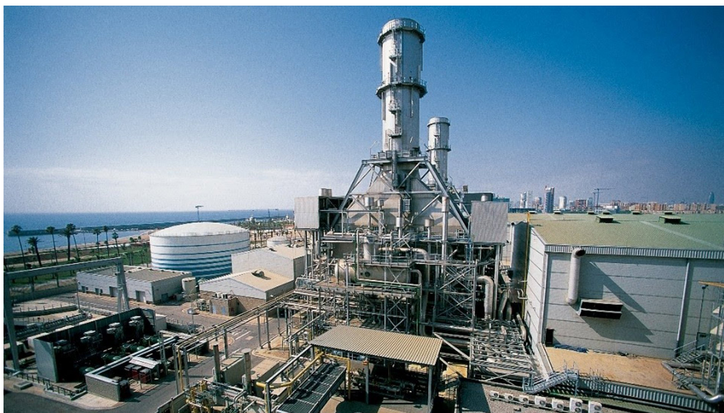
Central térmica de ciclo combinado (CTCC) de Endesa en Sant Adrià de Besòs (Barcelona).
