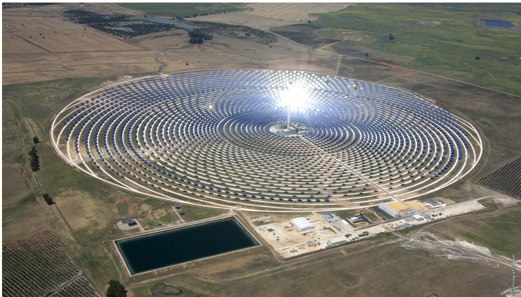
La energía termosolar generó 3.691 GWh en 2025, un 32% durante la noche.
