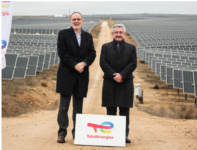
TotalEnergies pone en marcha un parque fotovoltaico de 59 MW en Seseña (Toledo).
