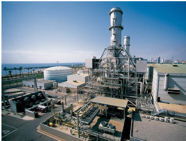
Central térmica de ciclo combinado (CTCC) de Endesa en Sant Adrià de Besòs (Barcelona).
