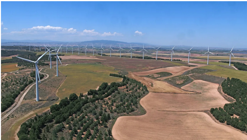
Parque eólico Montes de Cierzo antes de la última fase de la repotenciación de Statkraft.
