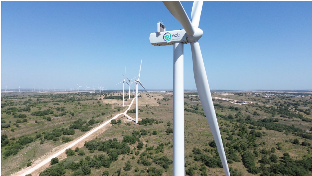
Parque eólico Ubierna de EDP.
