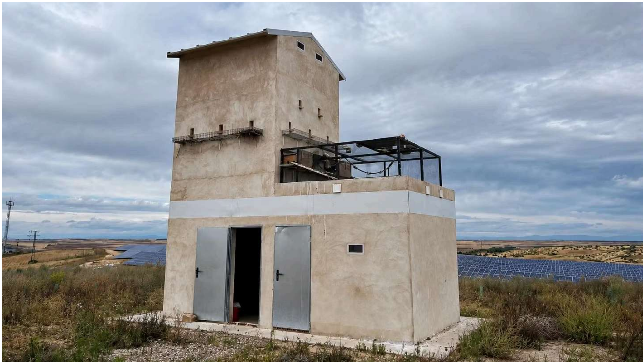
Planta Fotovoltaica de Bargas. Iberdrola.
