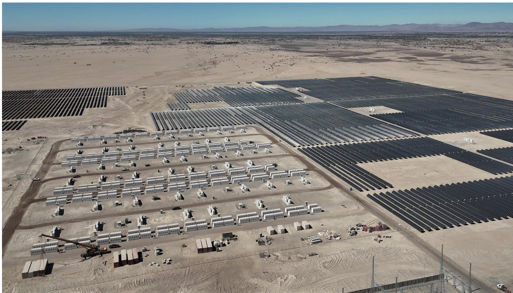
Seguidores solares 'TracSmarT+1P' de Gonvarri Solar Steel.
