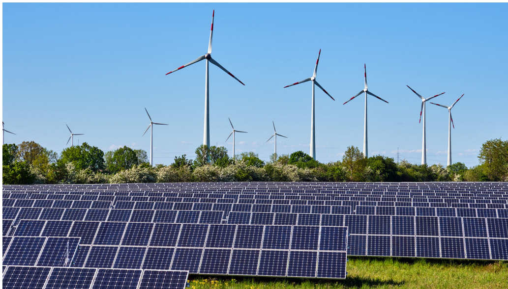
Instalaciones renovables de Qualitas Energy.
