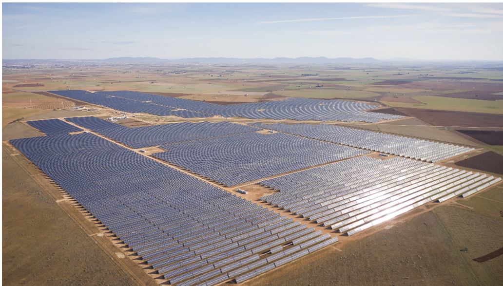
Planta fotovoltaica Manzanares de Nexwell Power.
