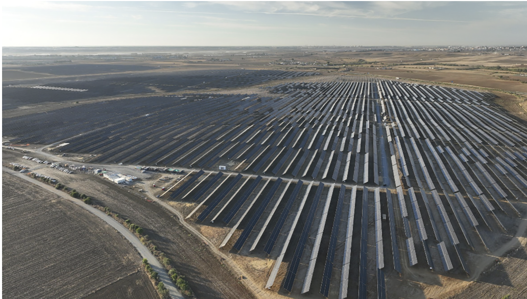
Proyecto solar de Alter Enersun La Luz en Huelva.
