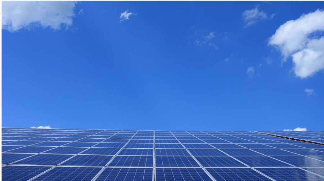
El PP del impuesto al Sol suprimirá el impuesto a la generación eléctrica
