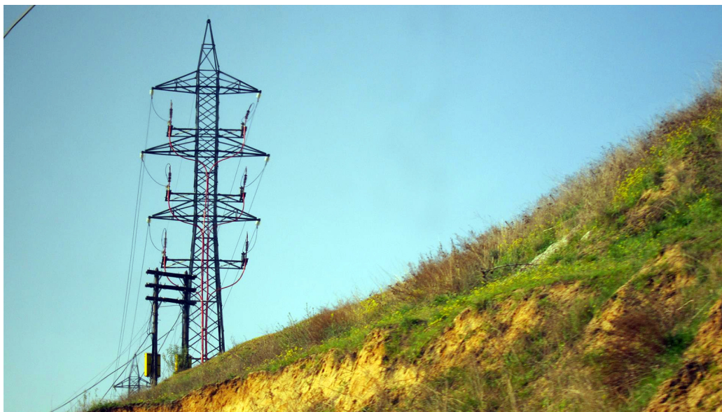
Tendido de electricidad.
