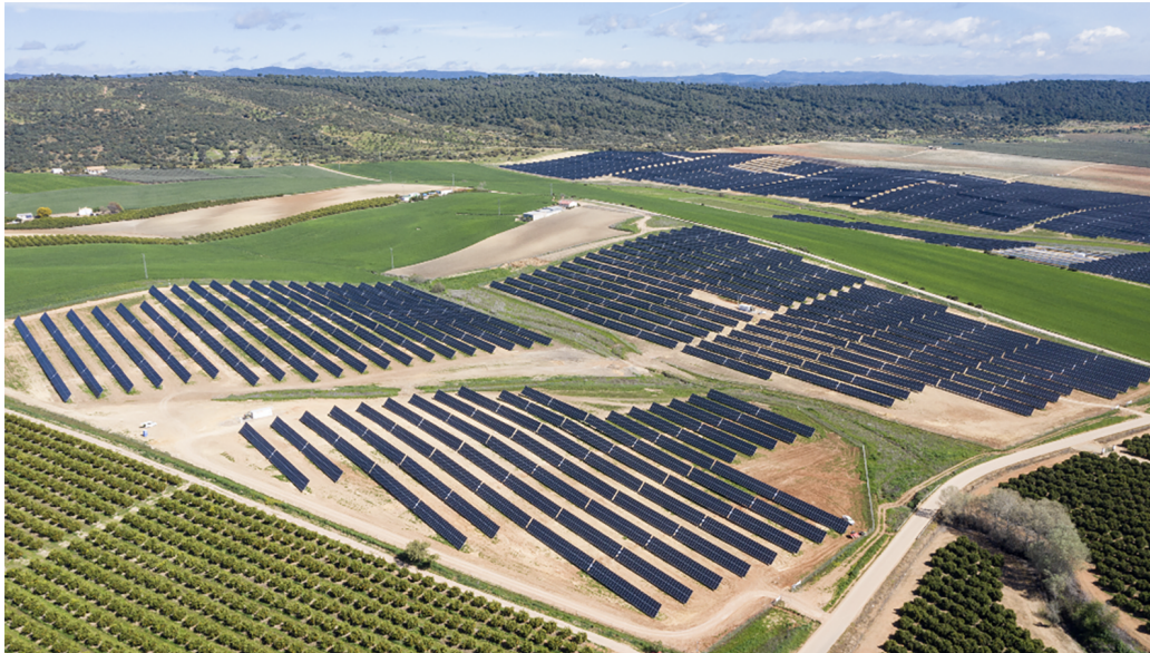
Planta fotovoltaica Posadas de Nexwell Power.
